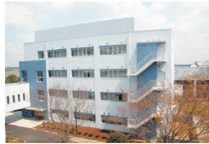
スポーツ健康医科学研究所 2006（平成18）年竣工
